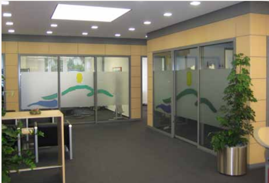
▲ Beraterräume mit geschmackvollen und akustisch wirksamen Glastrennwänden
