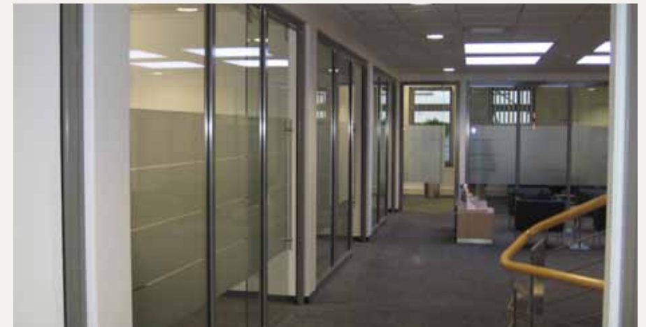
▲ Dank dieser gelungener Glastrennwandlösung kommt das Tageslicht von allen Seiten in den Flurbereich
